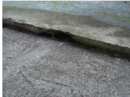
圖 7 運動場下坡面懸臂式擋土排樁頂 PC 陷落
