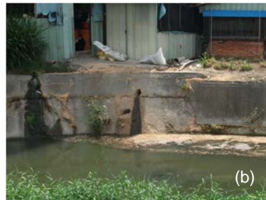
圖 4 影響河川水質之因子。(a)下游控制水位之頭汴埤制水閘門；(b)畜牧廢水。
