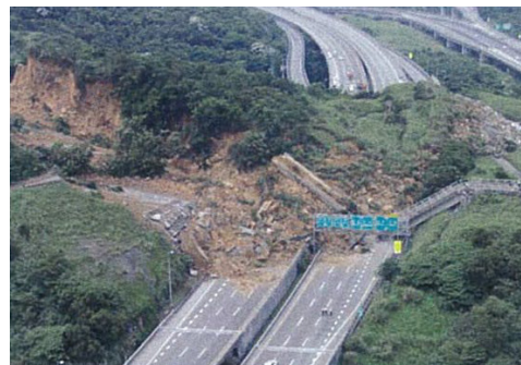
圖 4 崩塌現場空拍照片(交通部，2010 b )
