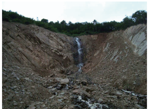
圖5 廟壩滑坡形成的V型槽及後緣出露的泉水
