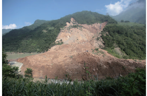
圖4 廟壩滑坡全景
