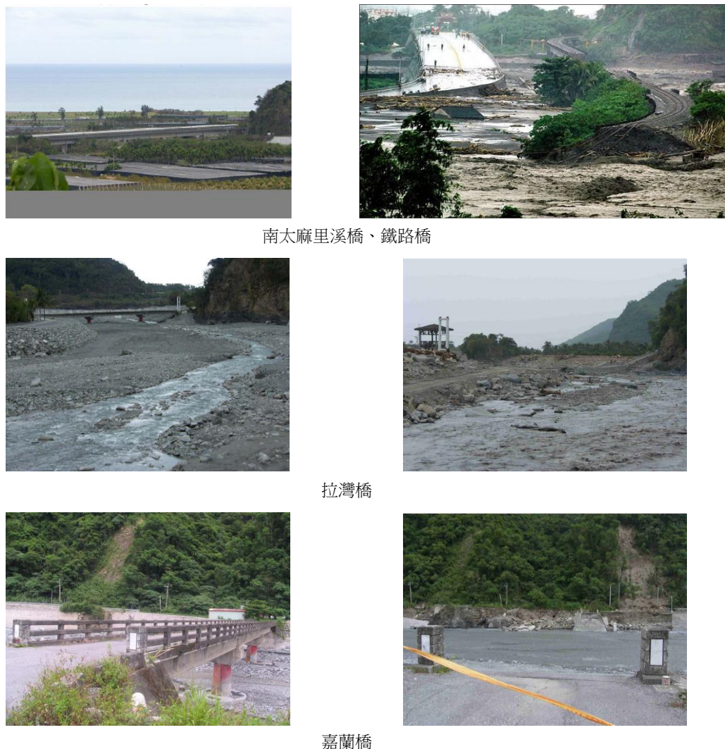
圖7 太麻里溪堤防橋樑受災照片
