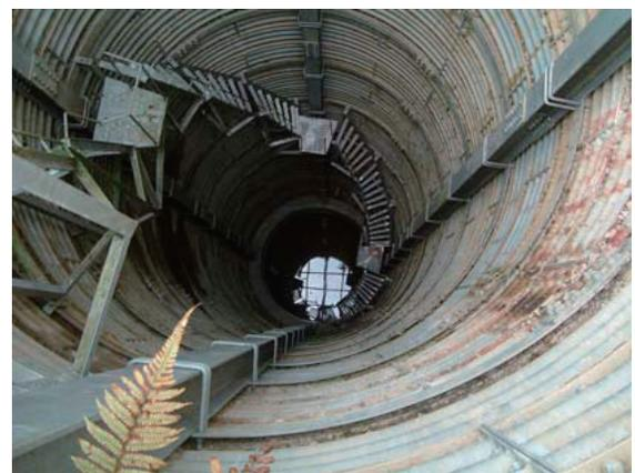
圖 24 大口徑集水井完工案例
